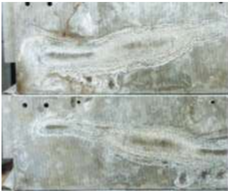
Figura 1. Manchas de almacenamiento en húmedo en una superficie galvanizada
